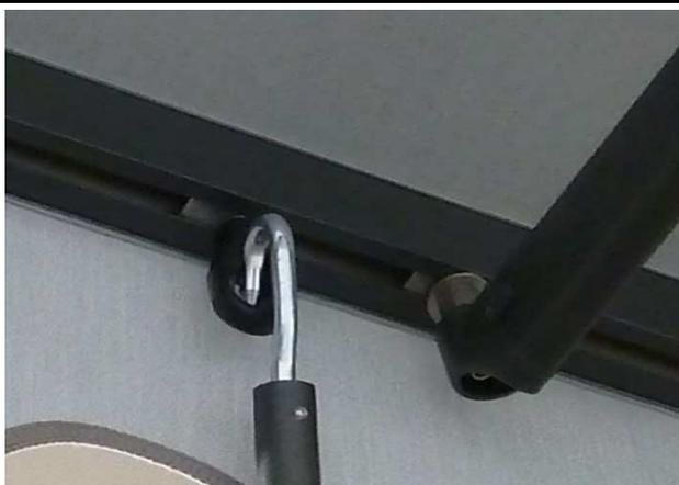
8. Hängen Sie den Haken der Teleskopstütze in die am Ausfallprofil befestigte Öse. Wiederholen Sie den Vorgang auf der anderen Seite.
