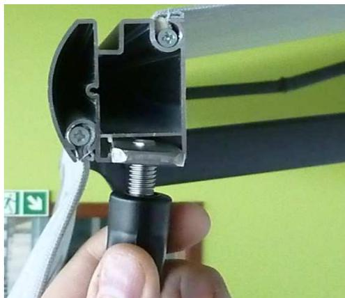
4. Lösen Sie die Schraube des Ösenhalters durch Herausdrehen vom Metallplättchen, um ihn leichter in der dafür vorgesehenen Nut des Ausfallprofils montieren zu können. Wiederholen Sie den Vorgang auf der anderen Seite.
