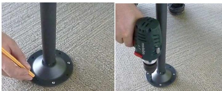
11. Markieren Sie die Position der Löcher für die Befestigung der Füße und bohren diese anschließend vor.
