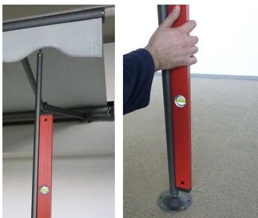
10. Richten die Teleskopstütze mithilfe einer Wasserwaage im Lot aus.
